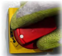
Abb. 61 Leistungsschalter zurücksetzen
