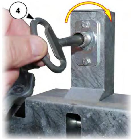
Abb. 46: Notentriegelung der Etagensicherungstür
